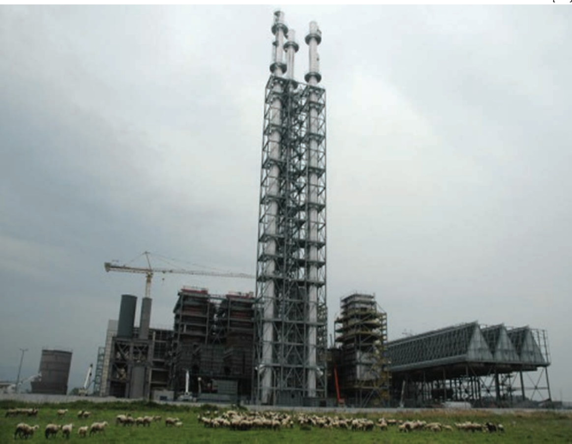
Inceneritore di Acerra in fase di costruzione [Na].
