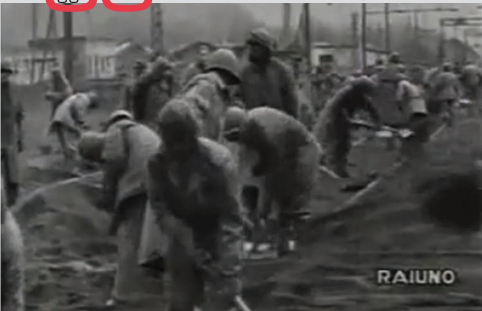
Fig. 4 Cenere e sabbia vulcanica di notevole spessore accumulatesi in poche ore sui binari della zona circumvesuviana che ha messo fuori uso la linea ferroviaria poche ore dopo l'inizio dell'eruzione del 1944. Una situazione simile potrebbe verificarsi, nel caso di un'eruzione simile a quella del 1944, nell'area pedemontana del Vesuvio.
