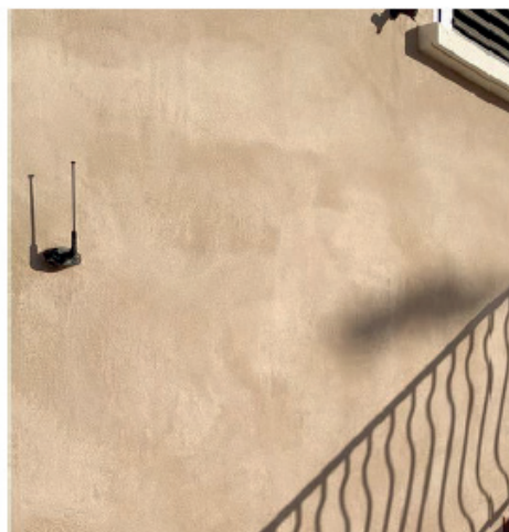
Fig. 7 Particolare della muratura interna dopo l'intervento di risanamento
