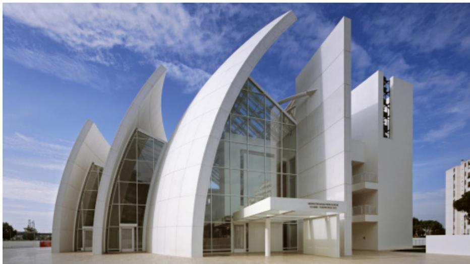
del terzo millennio, si è appoggiato alla Italcementi Group, che ha studiato e approntato appositamente per il progetto un nuovo cemento “bianco” con forti valenze tecnologiche, il TX Millennium al titanio che permette, grazie alla presenza di particelle di fotocatalizzatori, di ossidare in anidride carbonica, in presenza di luce, le sostanze inquinanti organiche ed inorganiche che venendo a contatto con le superfici cementizie mantengono inalterato l’aspetto originario nel tempo.
