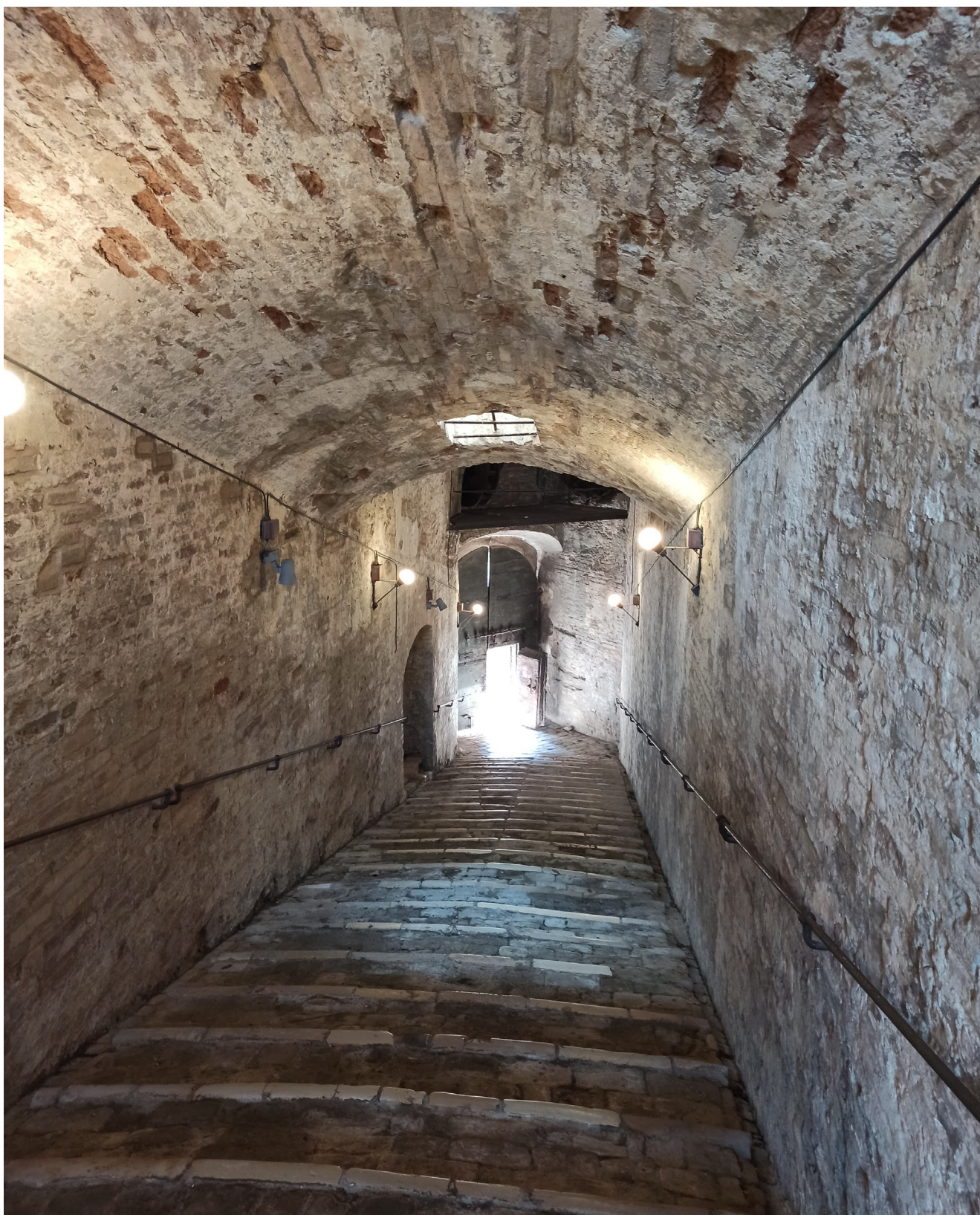
Fig. 116. Accesso alla Cittadella di Ancona (2023).
