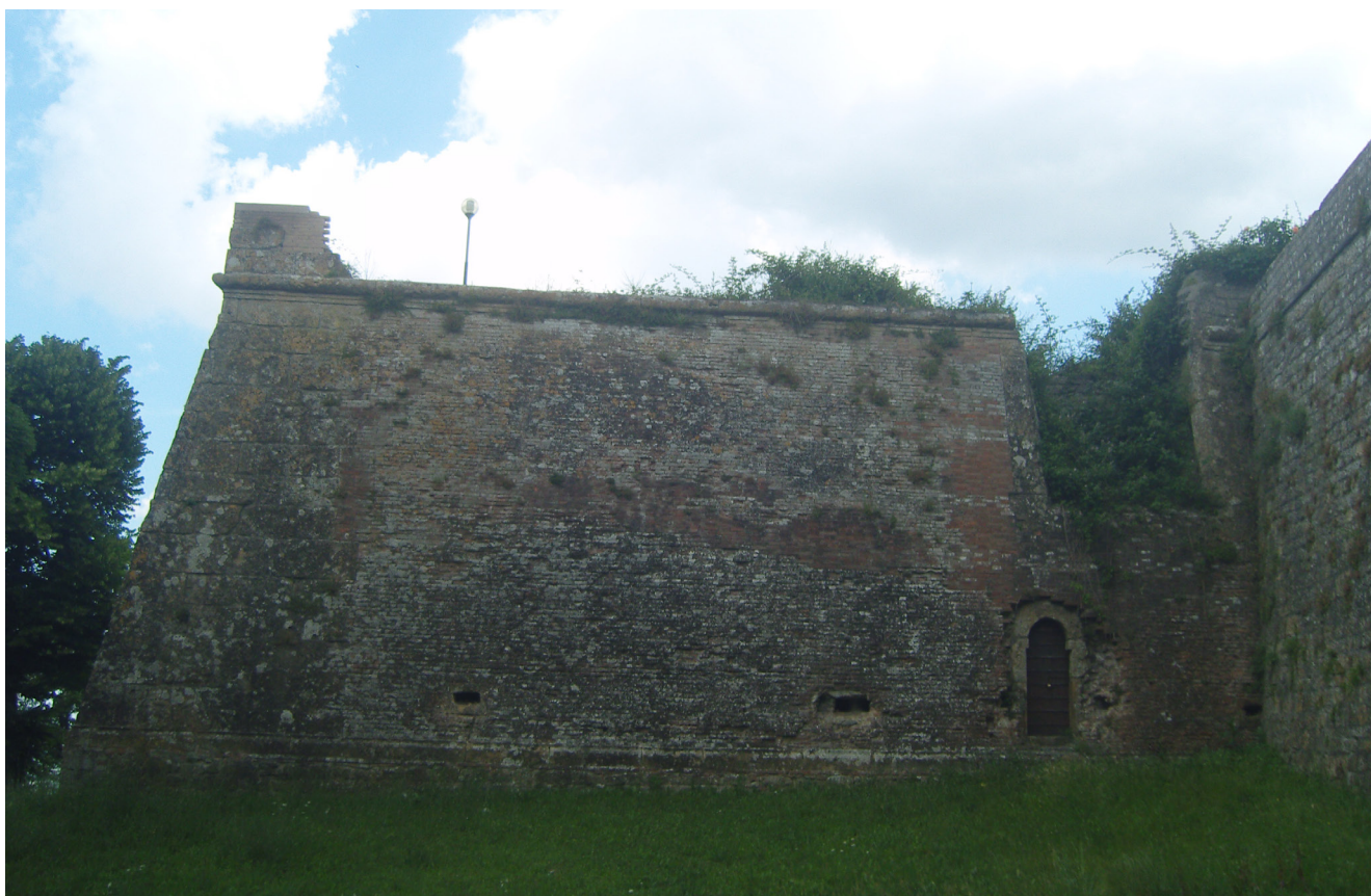
Fig. 155. Mura di Volterra. Parapetto inclinato (2011).
