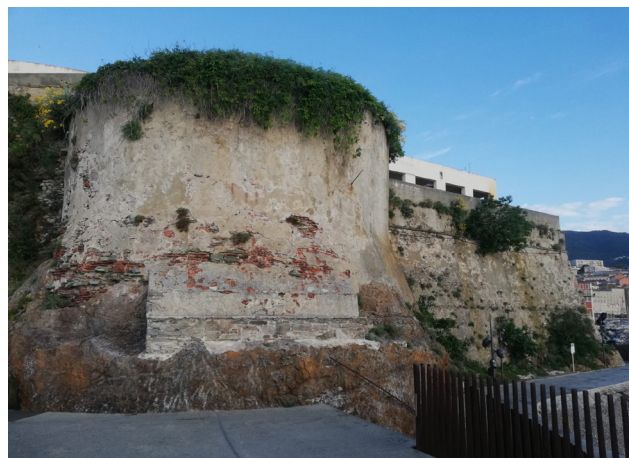
Fig. 45. Bastia. Torrione circolare dotato di scarpa e collegato alla nuova cortina "moderna" (2024).
