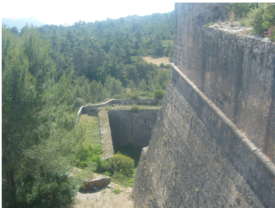
Fig. 126. Il forte di San Filippo a Setúbal in Portogallo (2010). Fossato e strada coperta.
