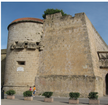
Fig. 2. Torre quattro-cinquecentesca che integra le bocche da fuoco con la difesa piombante di matrice medievale (2016).
