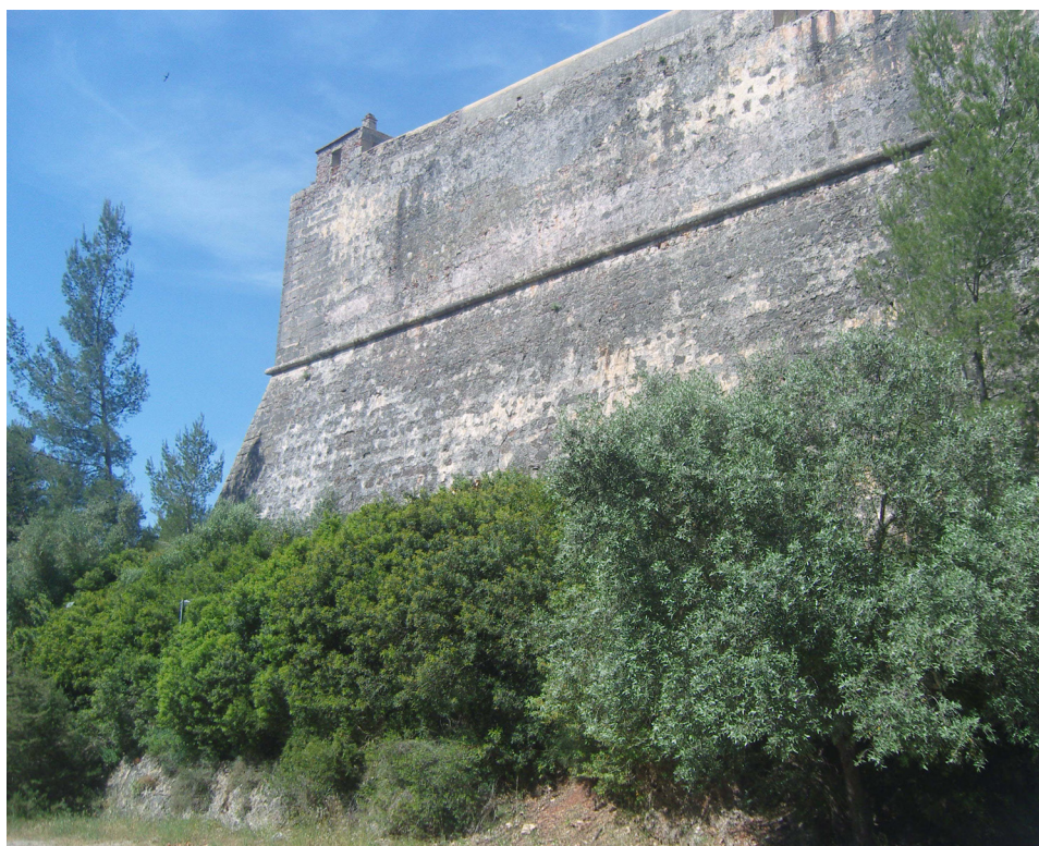
Fig. 125. Il forte di San Filippo a Setúbal in Portogallo (2010). Profilo scarpato, cordone e parapetto.
