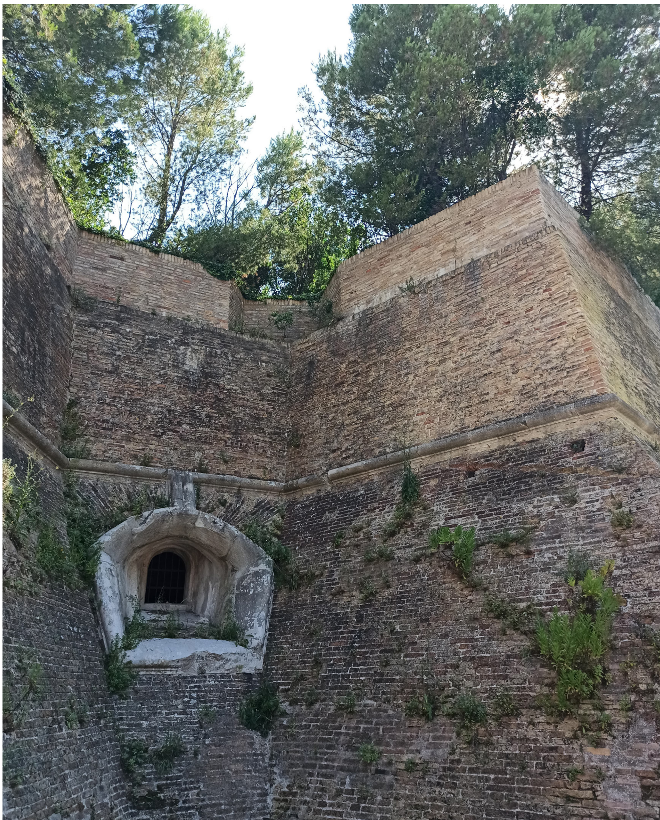
Fig. 117. Cannoniera al servizio della Cittadella di Ancona (2023).
