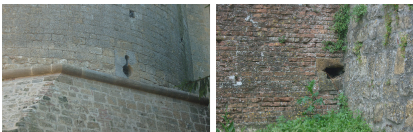
Fig. 17. Mura di Volterra. Le bocche di volata a chiave rovesciata inserite nella muratura sono in funzione di una particolare artiglieria, legata con canapi su cavalletti di legno e a canna lunga, caratteristica dell'epoca (2011).
