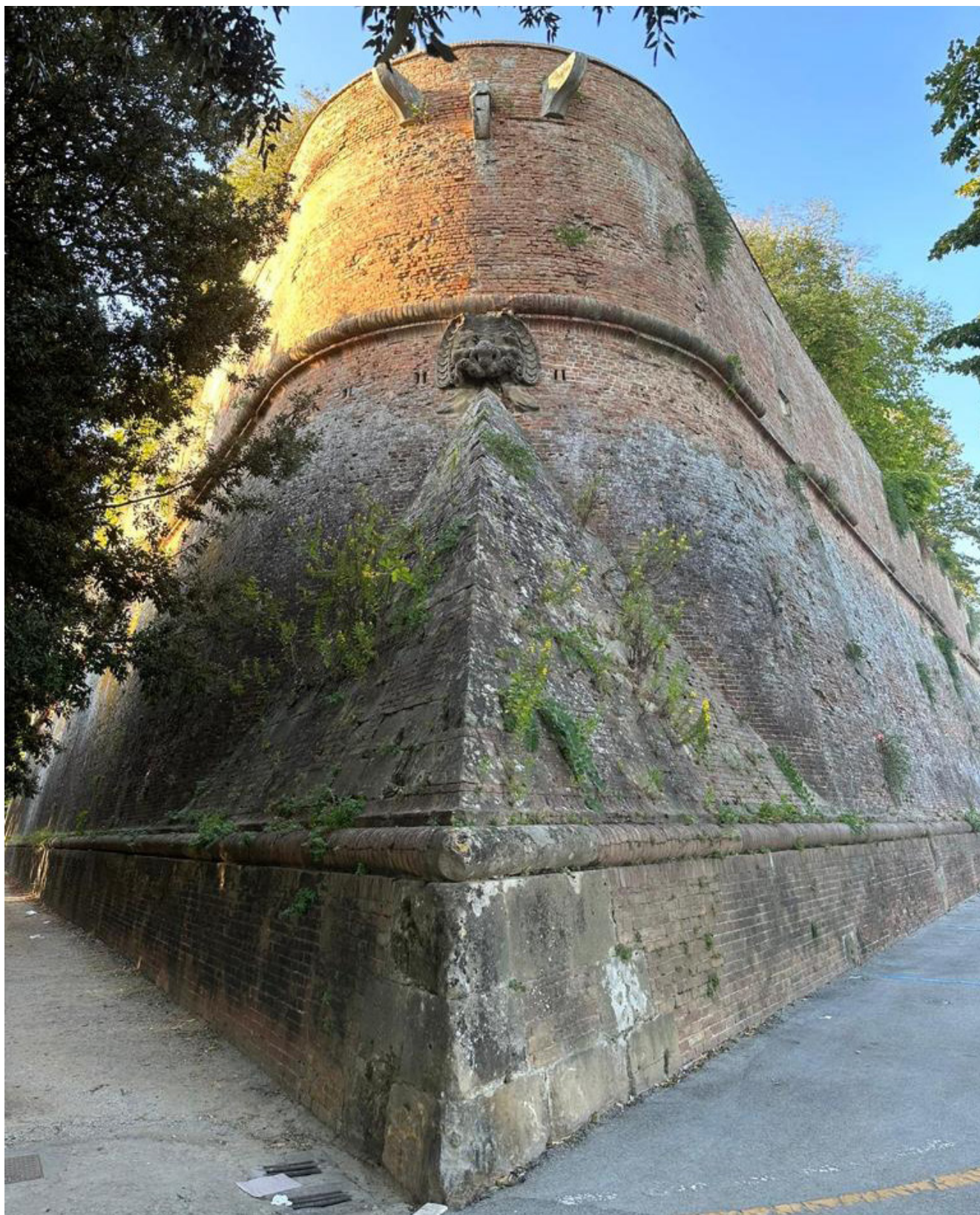
Fig. 73. Cittadella di Siena (2023). Sperone alla base del bastione progettato da Baldassarre Lanci (architetto militare allievo di Girolamo Genga).
