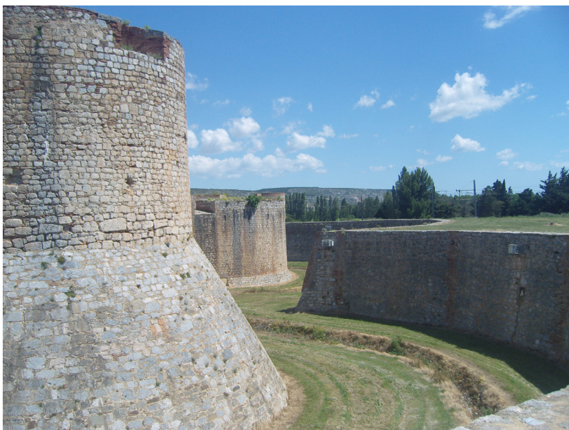
Fig. 4. Fortezza di Salses (Spagna) costruita da Ramiro López nel periodo 1497-1503. Torri cilindriche dotate di scarpa (2011).
