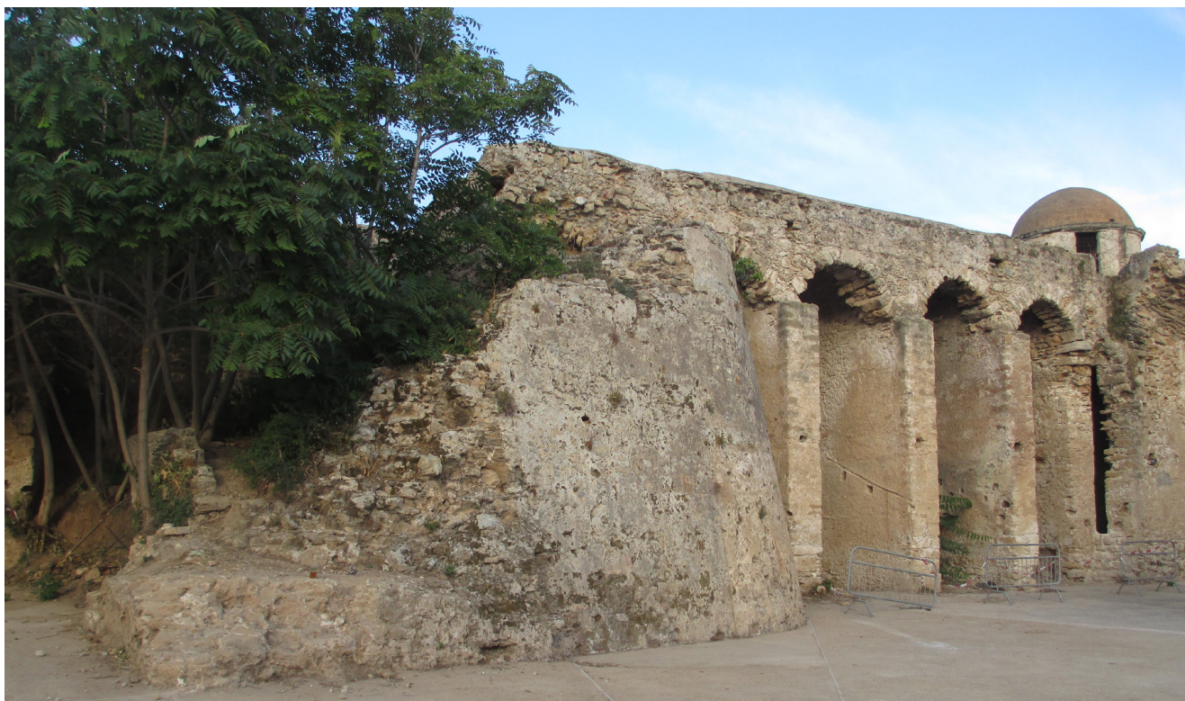
Fig. 154. Strutture murarie a sostegno del terrapieno nel bastione della Maddalena ad Alghero (2016).
